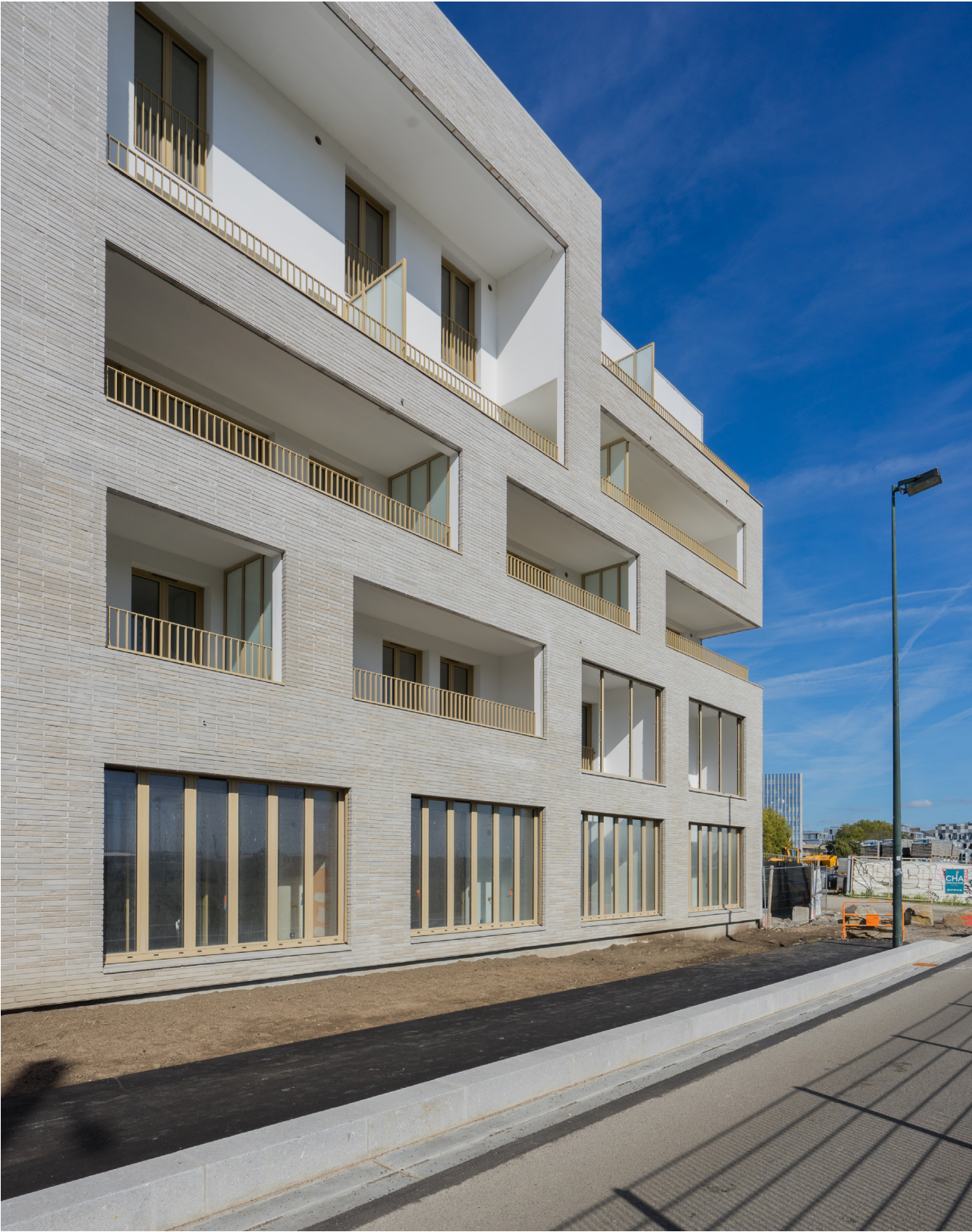
↑ façades en parement de briques de béton lisses et texturées, à rez-de-chaussée, mise à distance de la rue par des jardins d'hiver, en étage, loggias dans le prolongement des séjours
