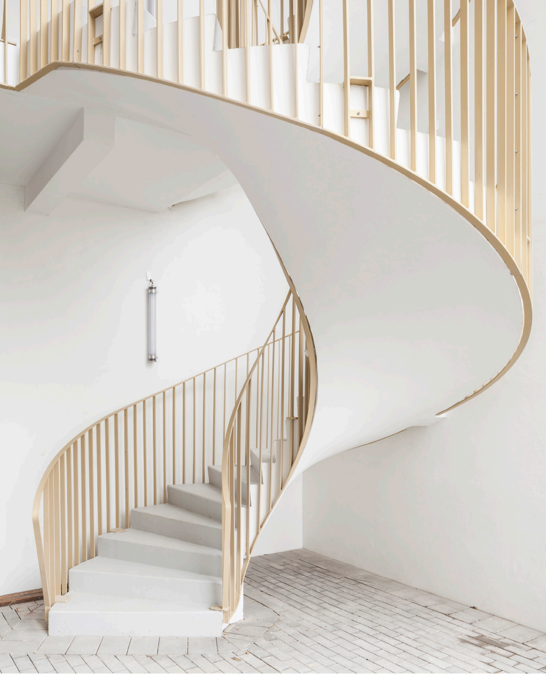
↓ escalier extérieur hélicoïdal sans fut central, desservant la toiture terrasse partagée du R+5
