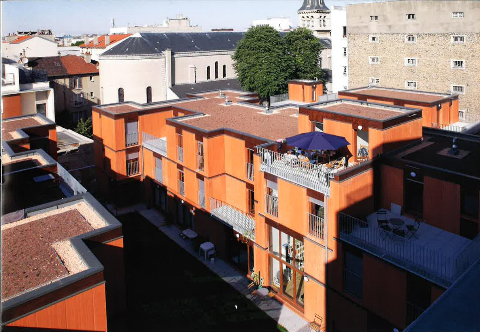
Densité, rétention des eaux par jardinières, toitures végétalisées, matériaux à haute inertie et dispositifs passifs (balcons filants faisant fonction de brise-soleil au Sud), sont autant
