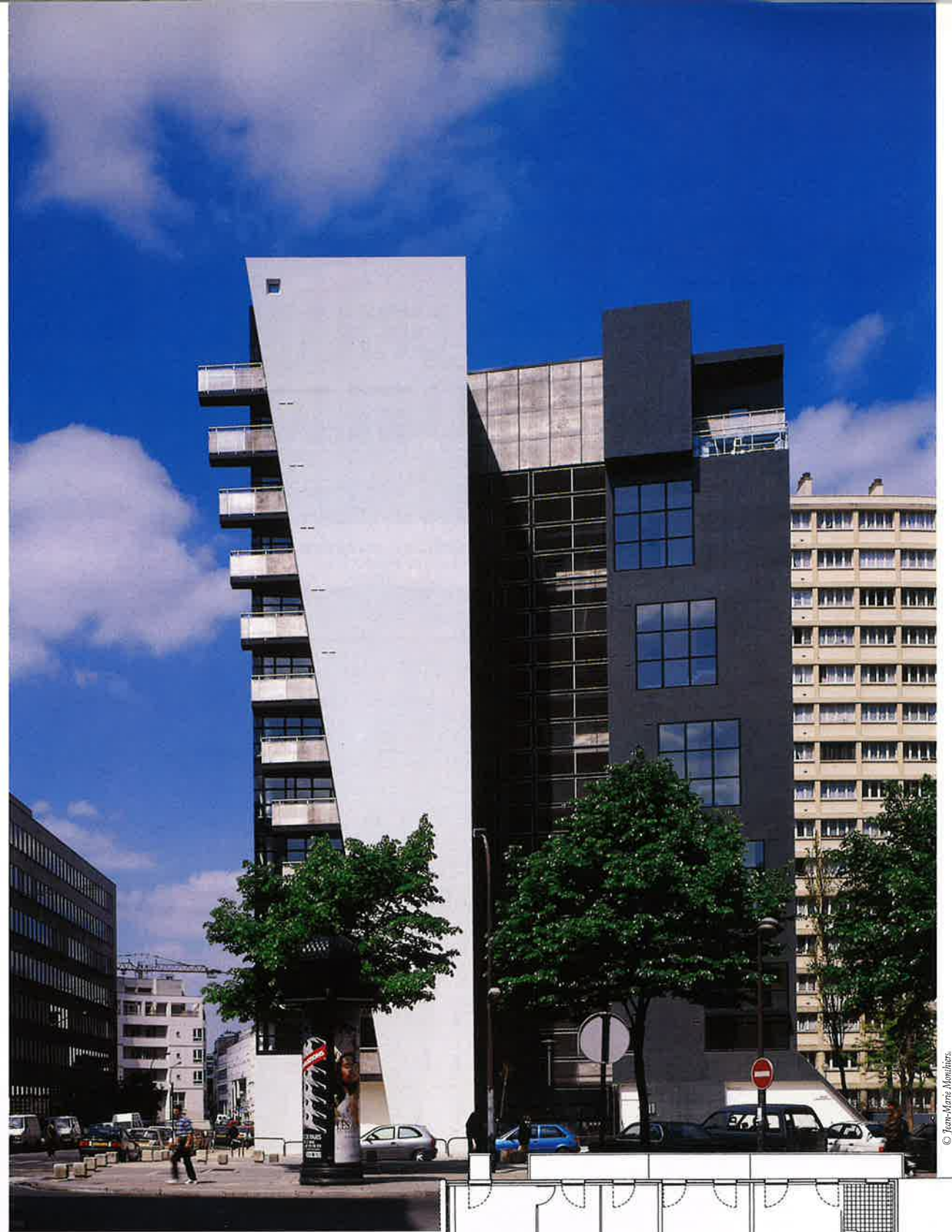
Un profil fragmenté en fuseaux pour démultiplier les orientations et les vues des logements.
