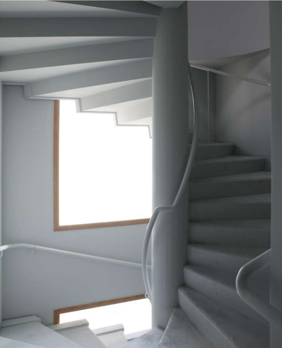
↑ Escalier commun éclairé naturellement, pour inciter son utilisation et limiter l'usage de l'ascenseur consommateur d'énergie
