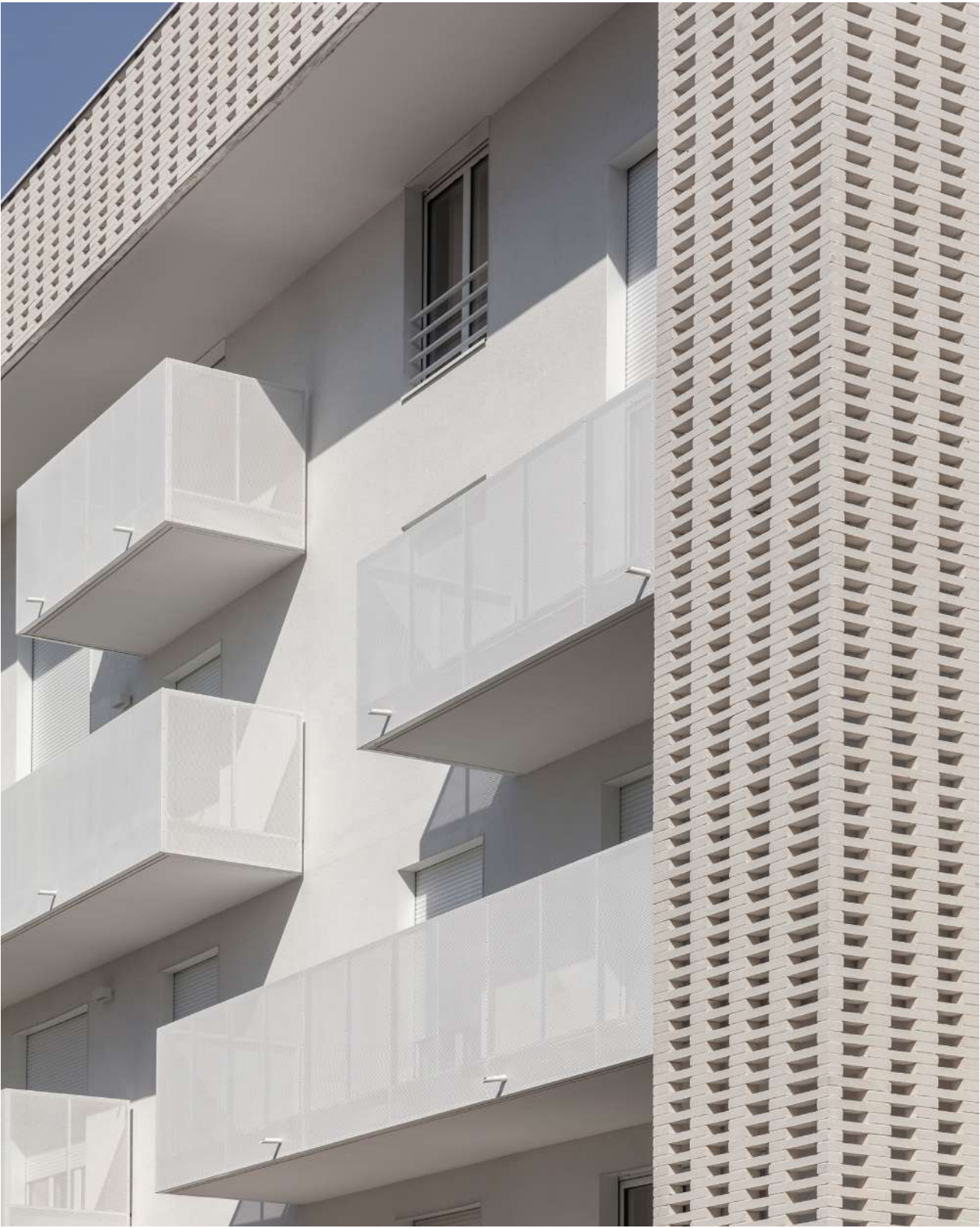
↓ appareillage des briques en Moucharabieh
