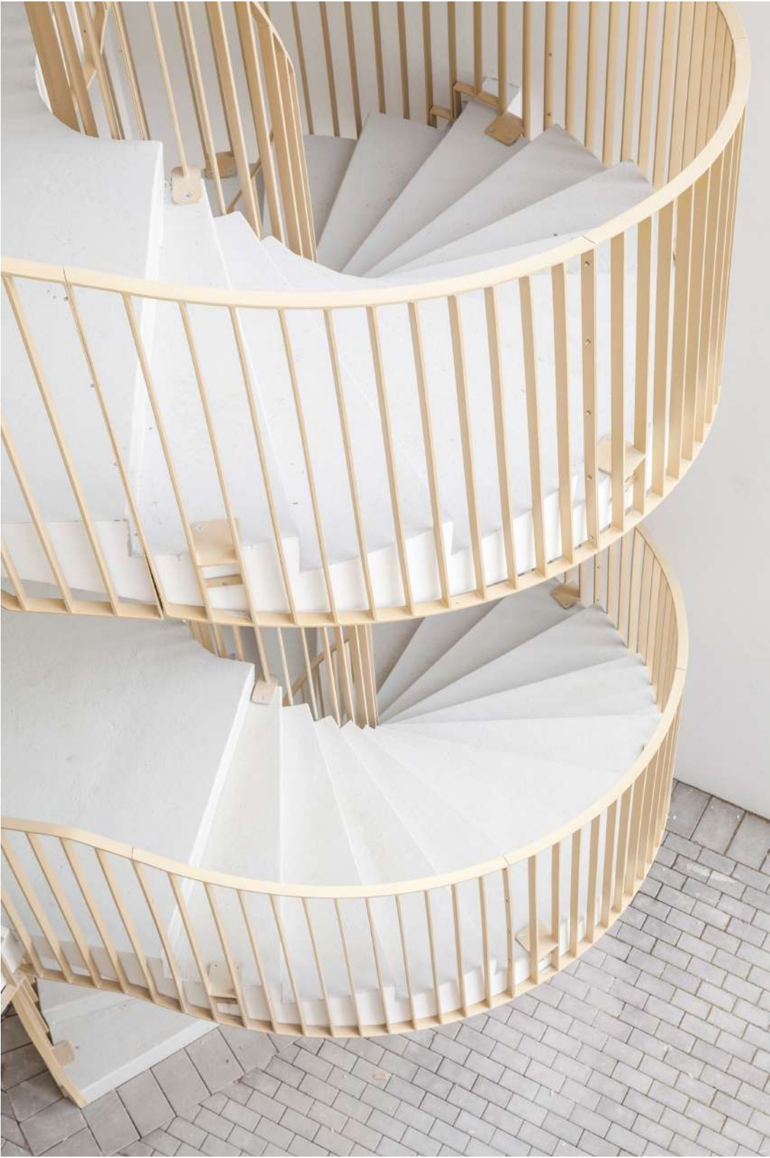
↓ escalier extérieur helicoïdal sans fut central, desservant la toiture terrasse partagée du R+5
