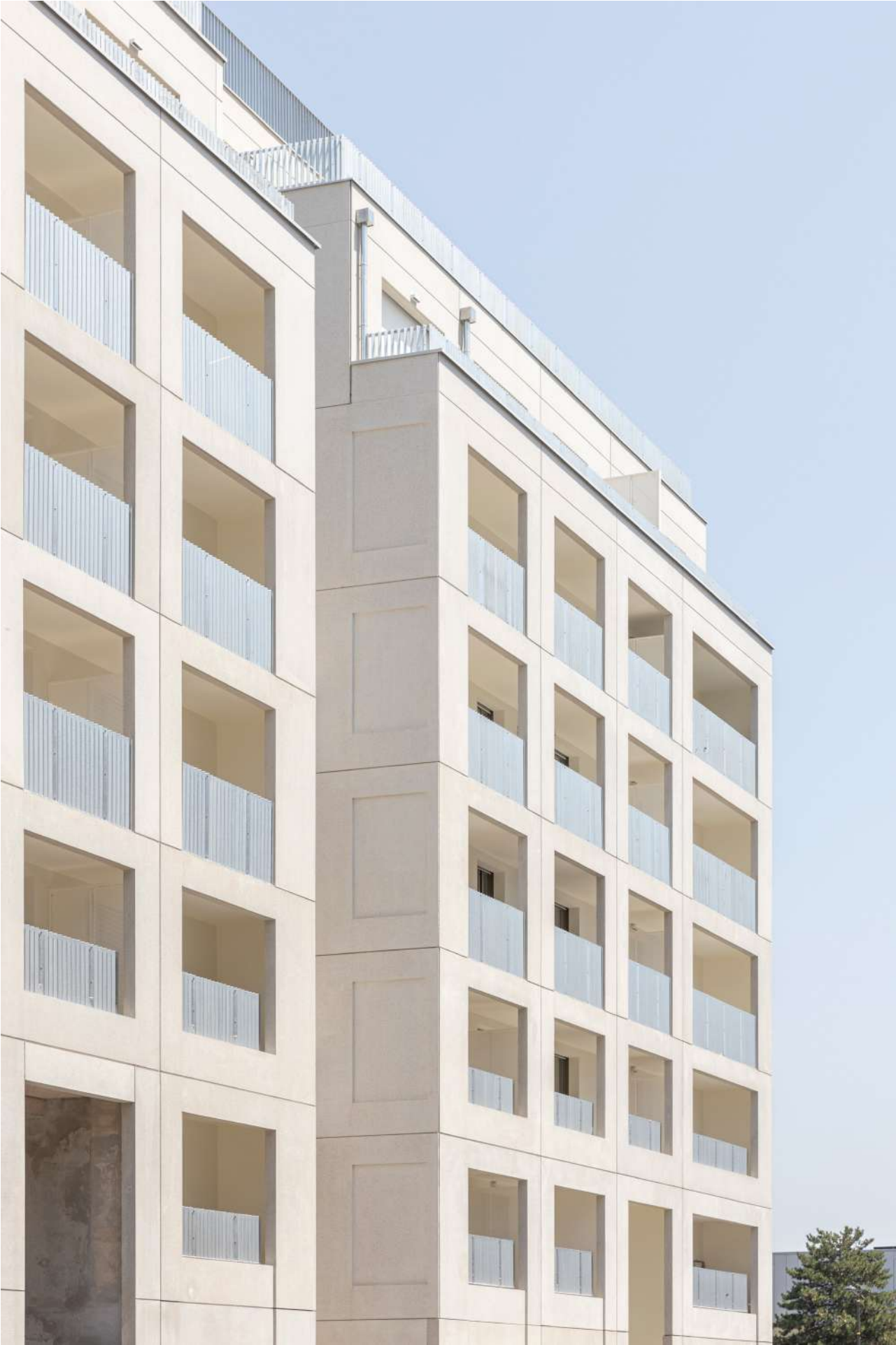
↓ parti architectural : façades tramées en béton préfabriqué pour une grande qualité de réalisation
