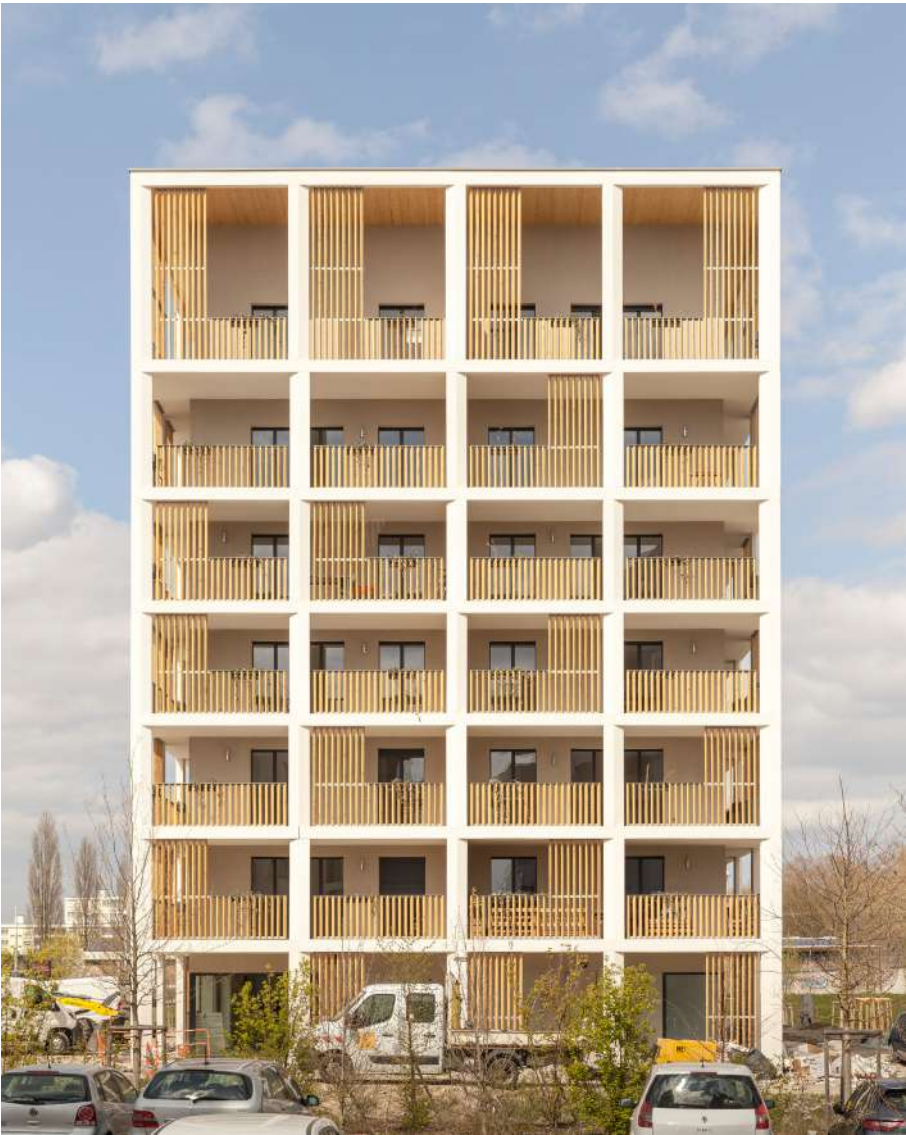
← façade Sud l'épaisseur des loggias et le dispositif de brise-soleil protègent les logements des effets de surchauffe l'été ↓ détail de façade les jeux de biais des lames des brise-soleil et des poteaux de l'exosqueltette animent la façade
