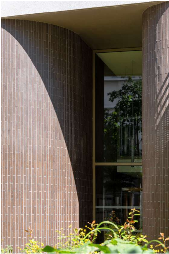
↓ façades courbées assurant la fluidité du plan masse parement en briques de terre cuite
