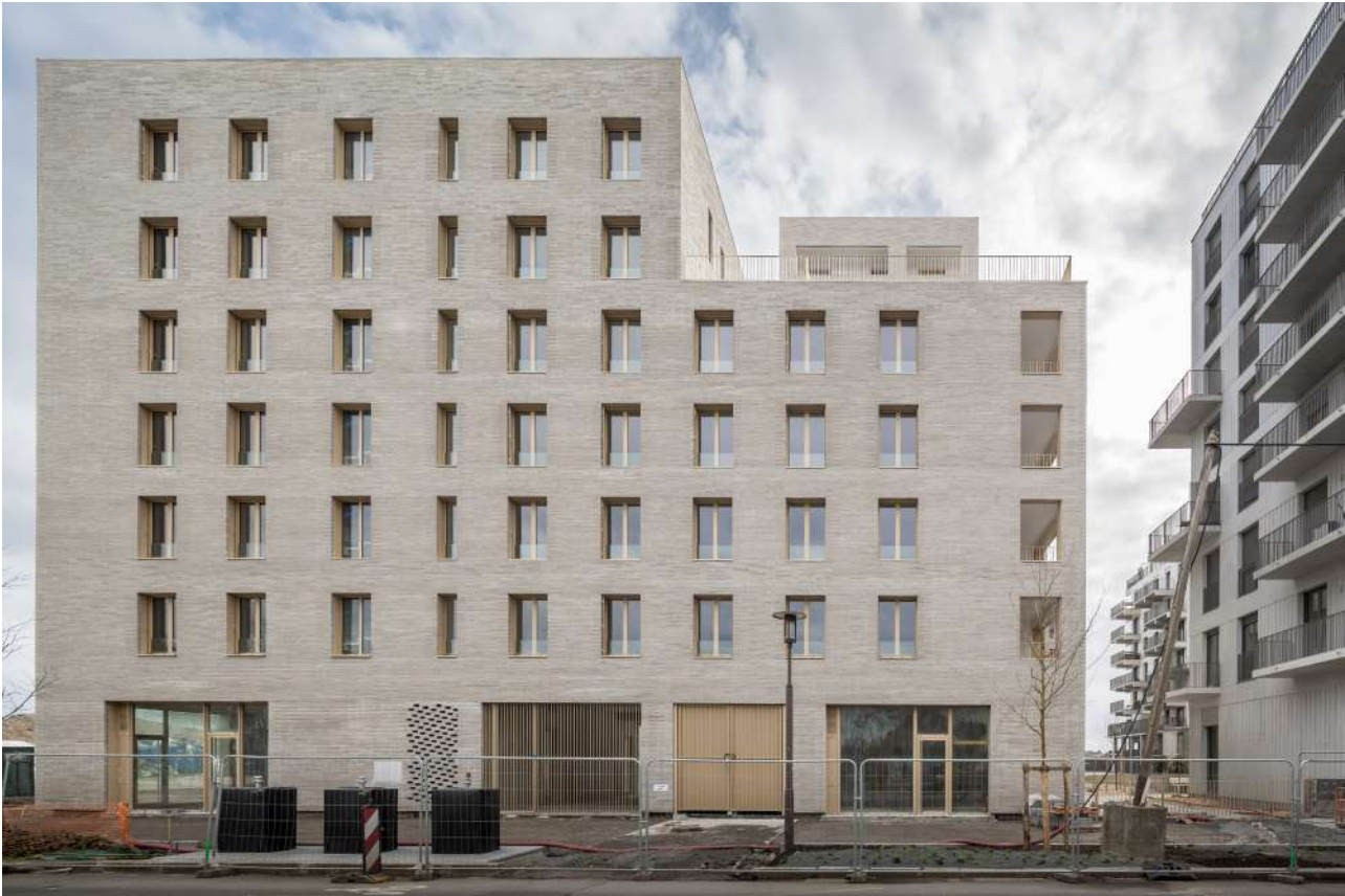
↓ matérialité et texture le parement en briques de béton lisses et texturées font vibrer la façade
