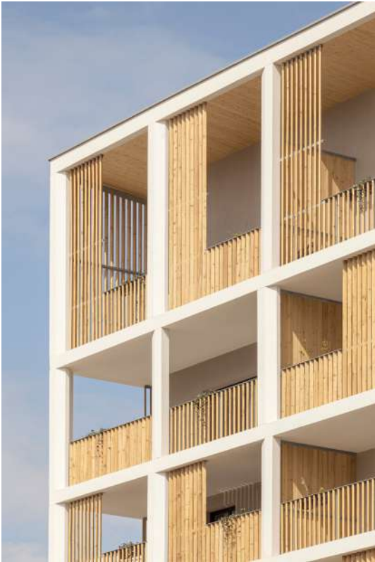
← façade Sud l'épaisseur des loggias et le dispositif de brise-soleil protègent les logements des effets de surchauffe l'été ↓ détail de façade les jeux de biais des lames des brise-soleil et des poteaux de l'exosqueltette animent la façade
