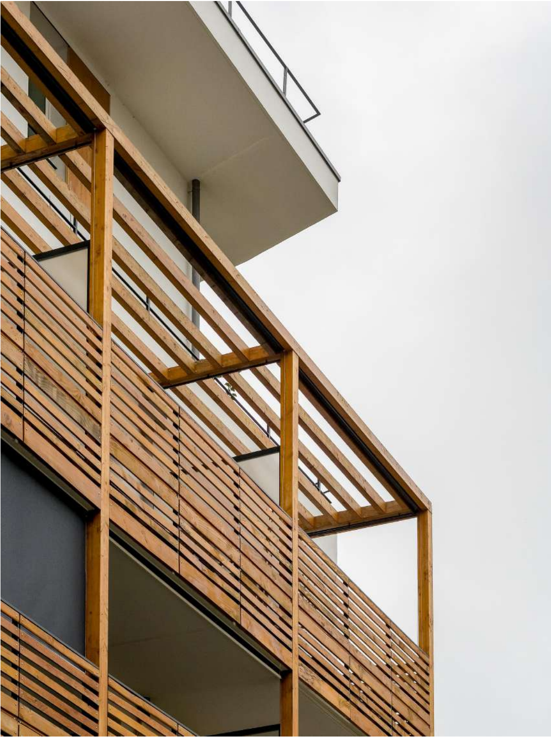
↑ desserte des logements en coeur d'îlot par coursives extérieures pour offrir des logements traversants protection solaire au moyen de stores sun-screen
