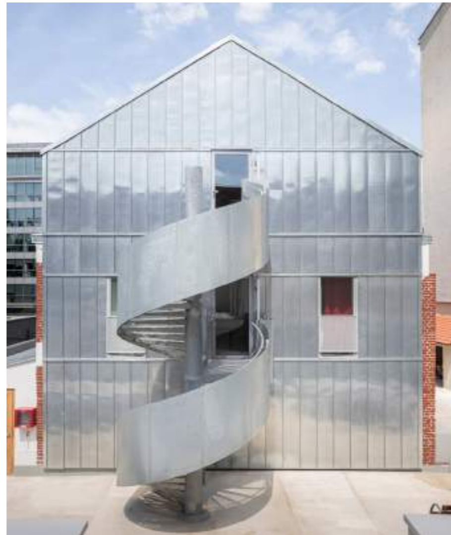
↓ escalier extérieur menant aux logements des compagnons
