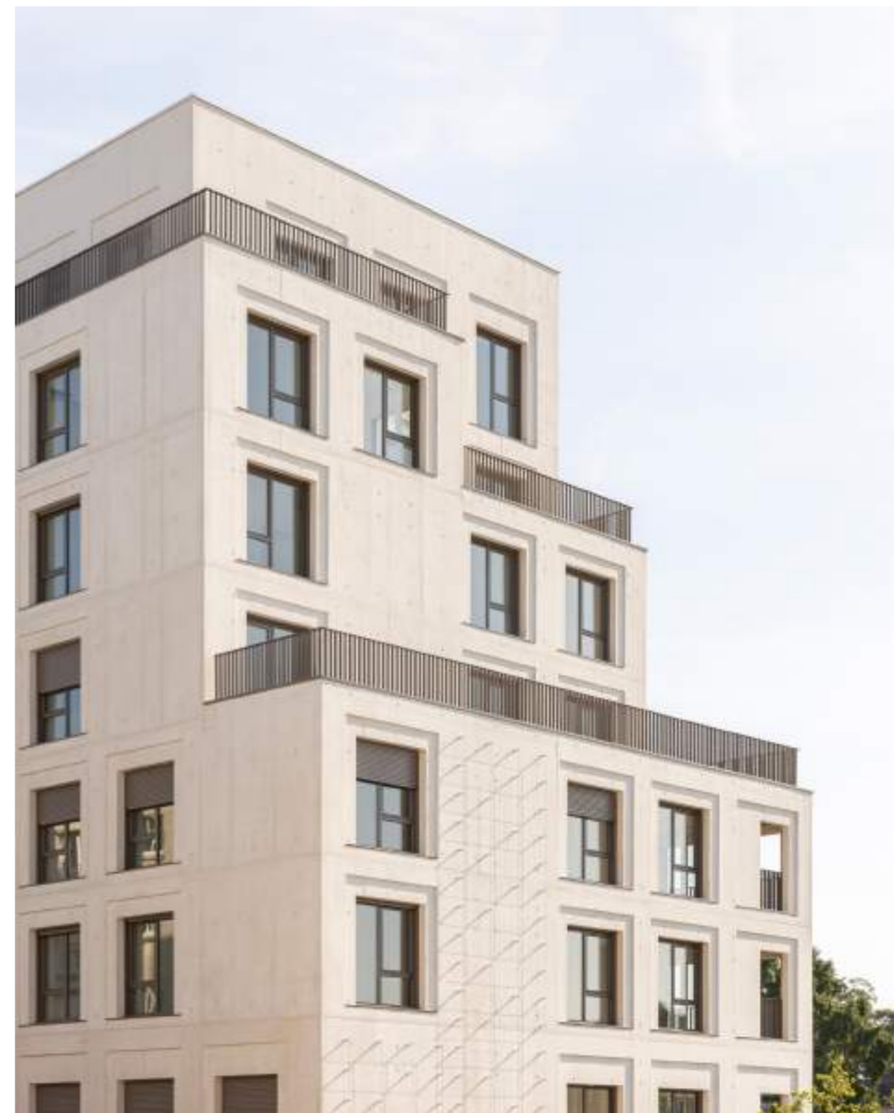
↑ travail de retraits en pignon, formant des terrasses privées en gradins
