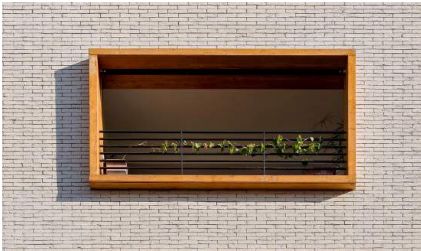
↓ façade trame composée de grands cadres en bois formant loggias, parement en briques de terre cuite moulée main, à joint sec
