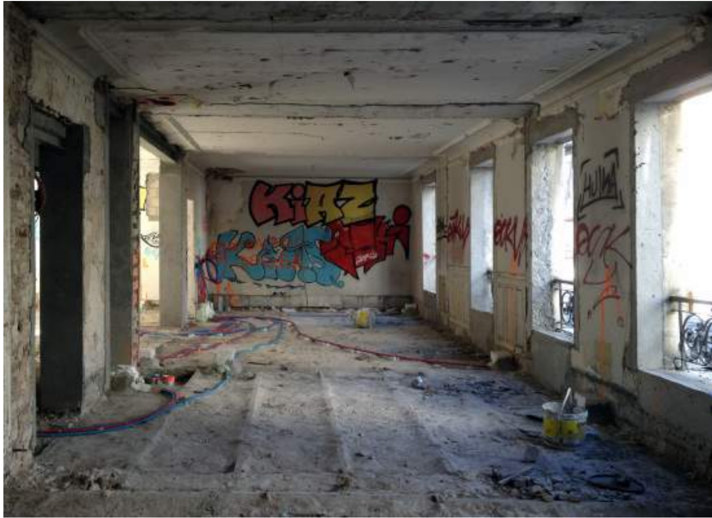
↑ curage du bâtiment de faubourg existant avant réhabilitation
