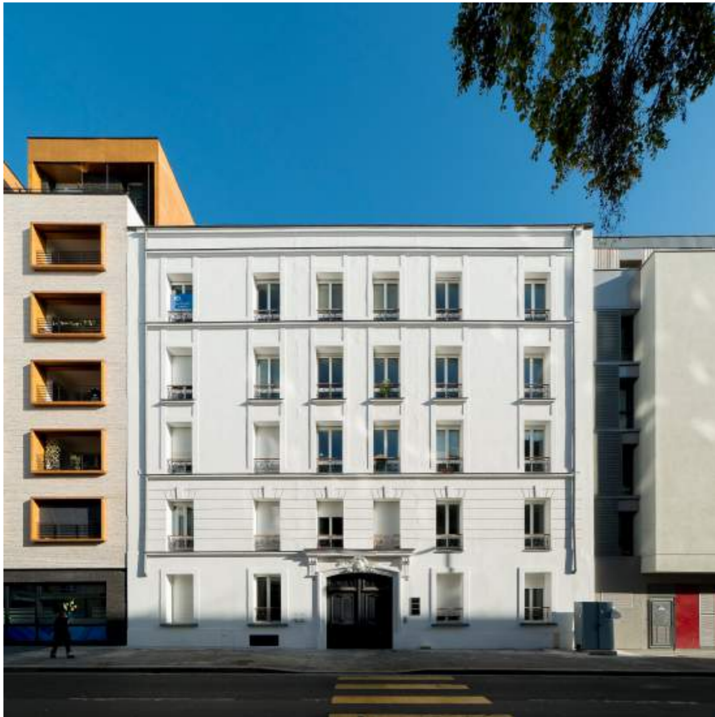
↑ le projet comporte la réhabilitation lourde d'un immeuble de faubourg et la construction d'un immeuble neuf
