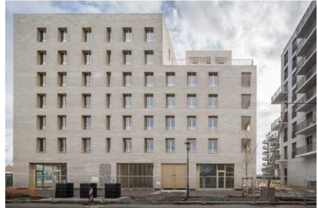
↓ matérialité et texture le parement en briques de béton lisses et texturées font vibrer la façade
