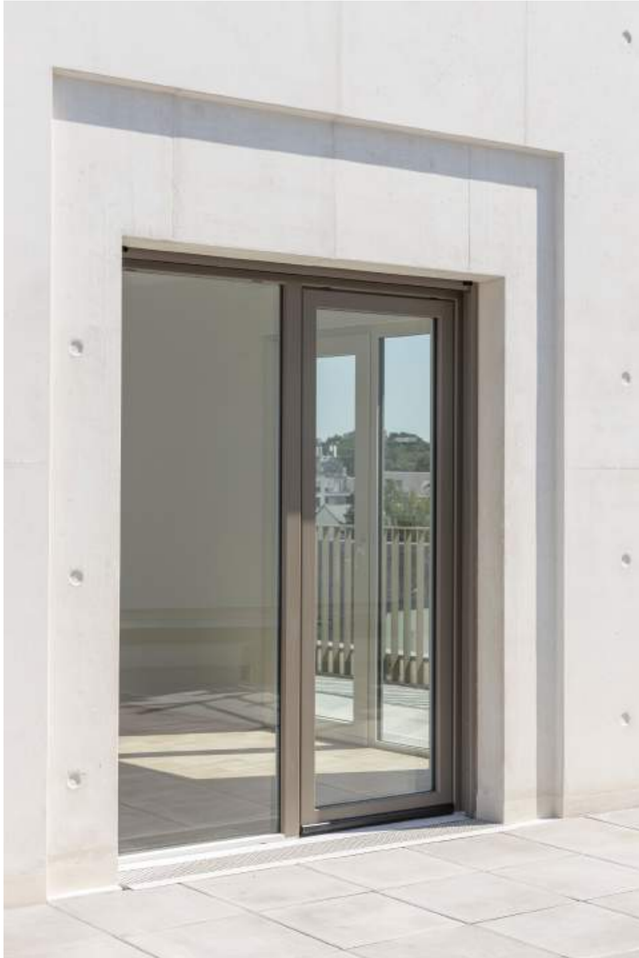
↑ façade en béton teintée dans la masse, avec tamponnement formant encadrement au droit de chaque baie
