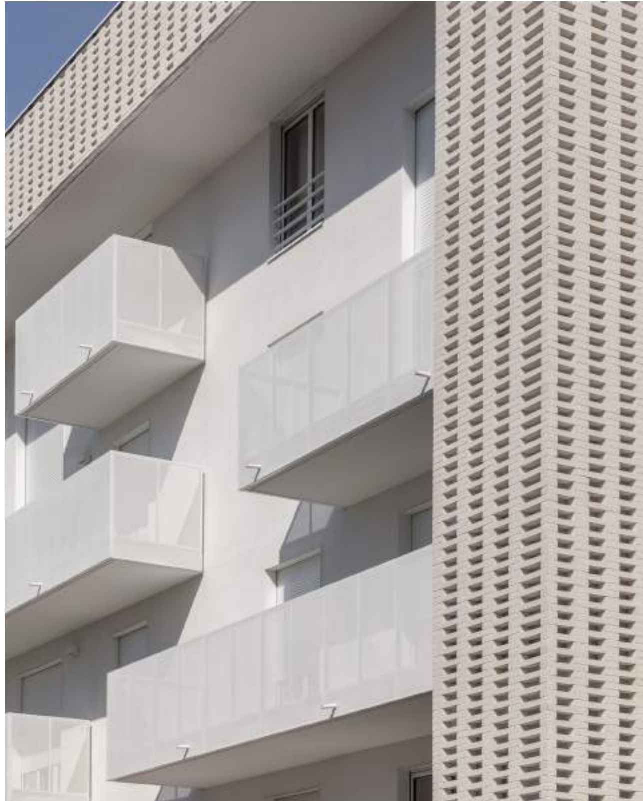
↓ appareillage des briques en Moucharabieh
