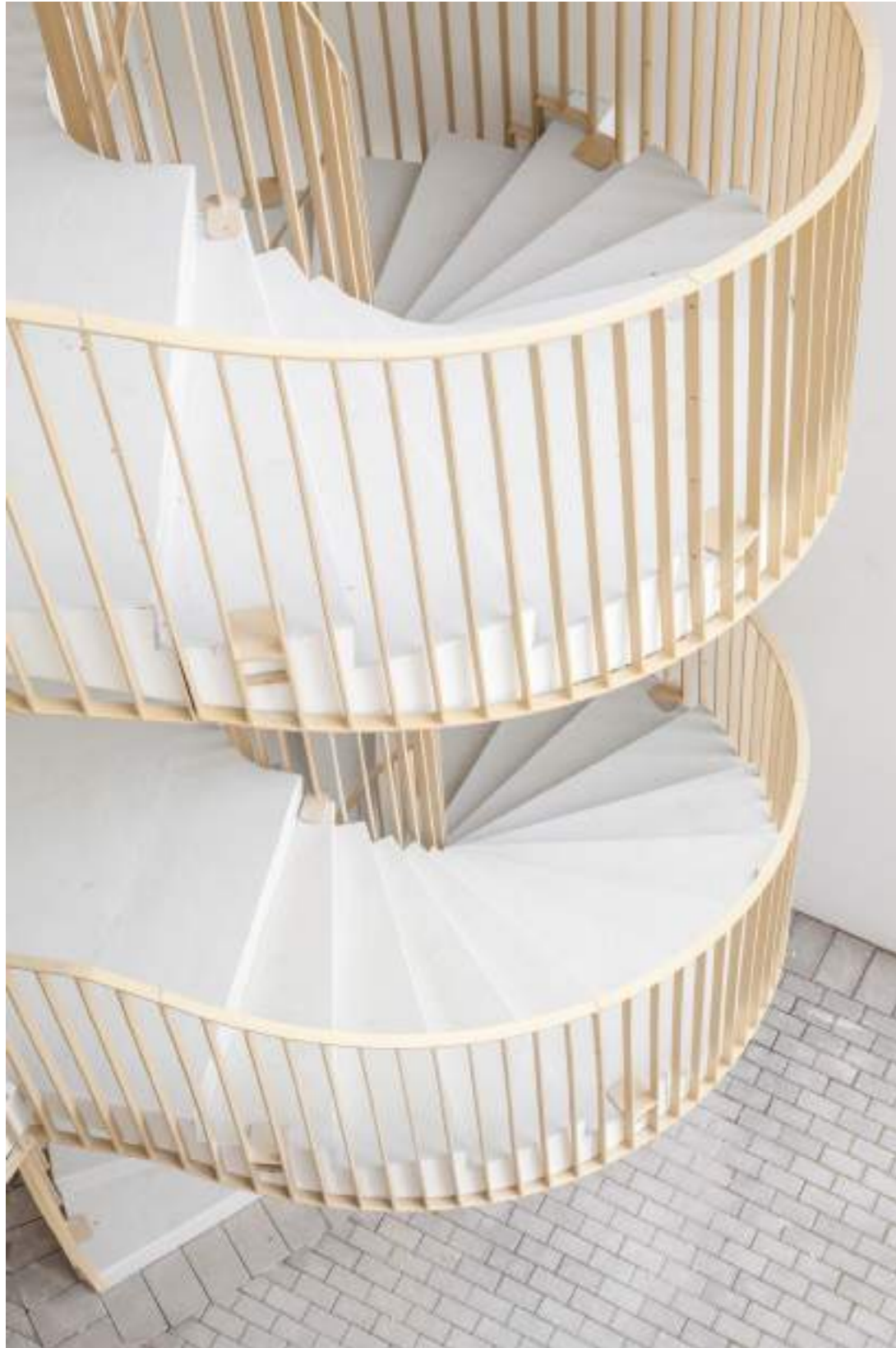
↓ escalier extérieur hélicoïdal sans fut central, desservant la toiture terrasse partagée du R+5
