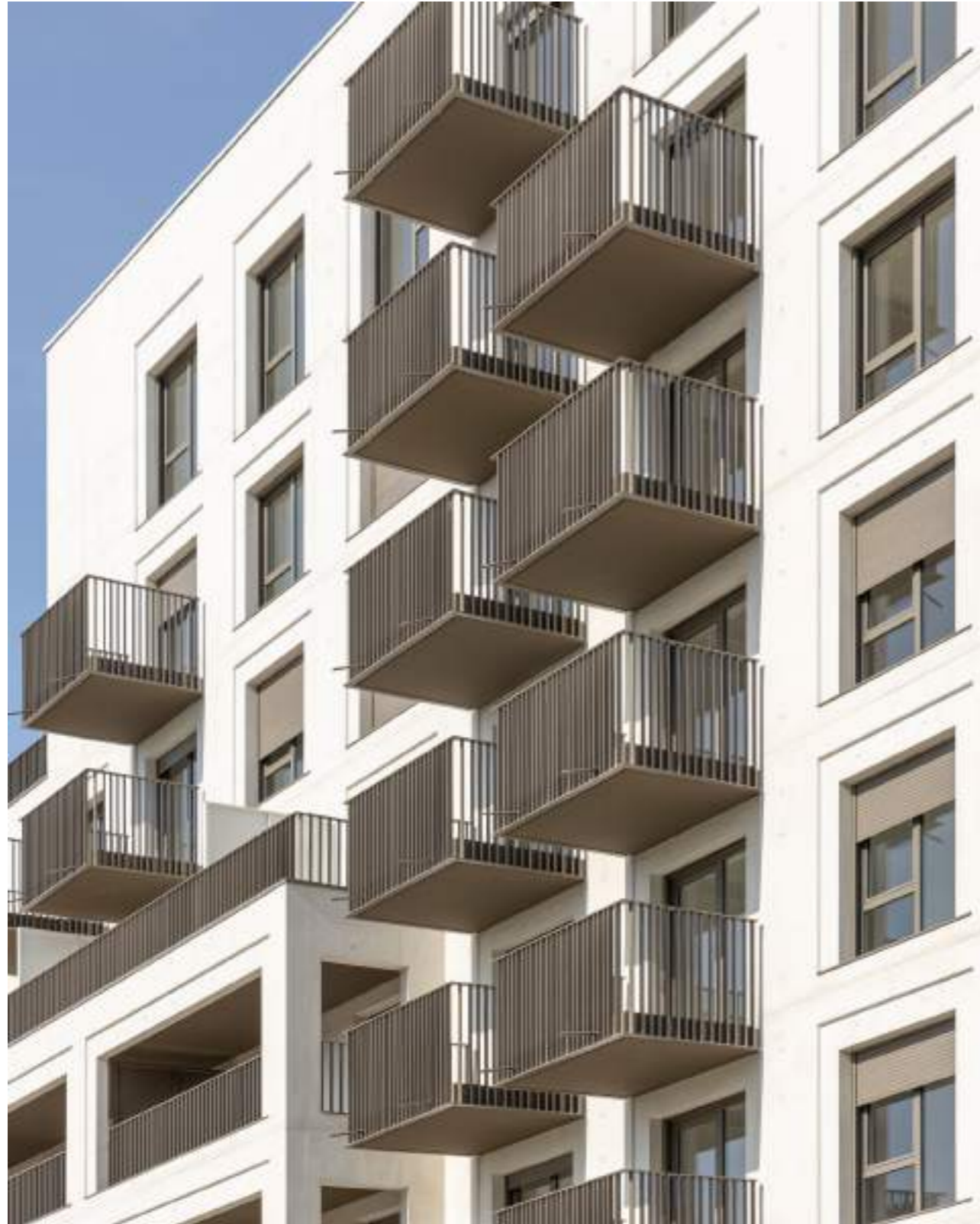
↑ façades tramées avec prolongements extérieurs privatifs sous forme de loggias ou balcons
