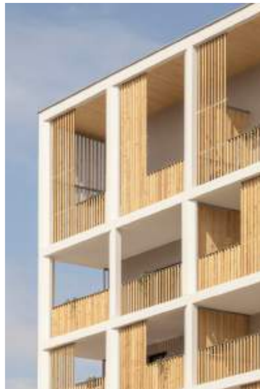
↓ détail de façade les jeux de biais des lames des brise-soleil et des poteaux de l'exosquelette animent la façade
