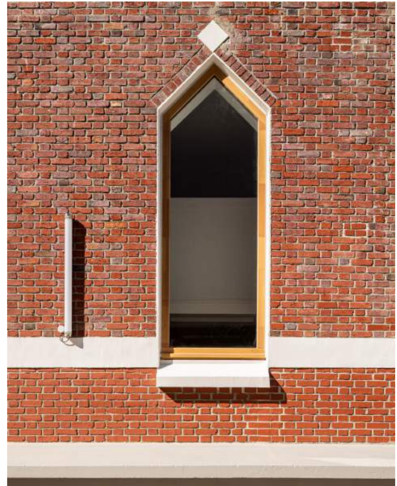
↓ réfection de la façade existante en brique
