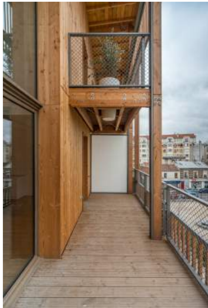
↓ Loggia en double hauteur dans le prolongement des séjours et balcon en haut de duplex
