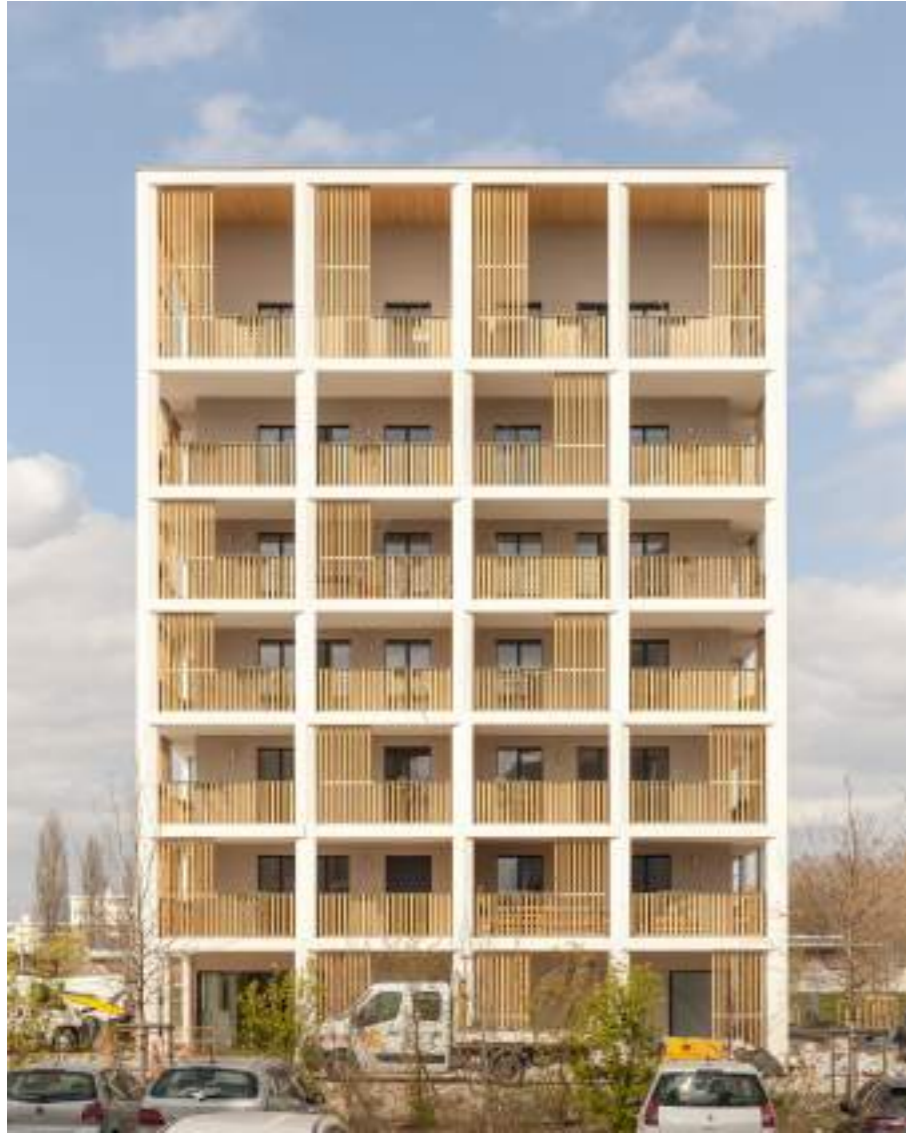
← façade Sud l'épaisseur des loggias et le dispositif de brise-soleil protègent les logements des effets de surchauffe l'été
