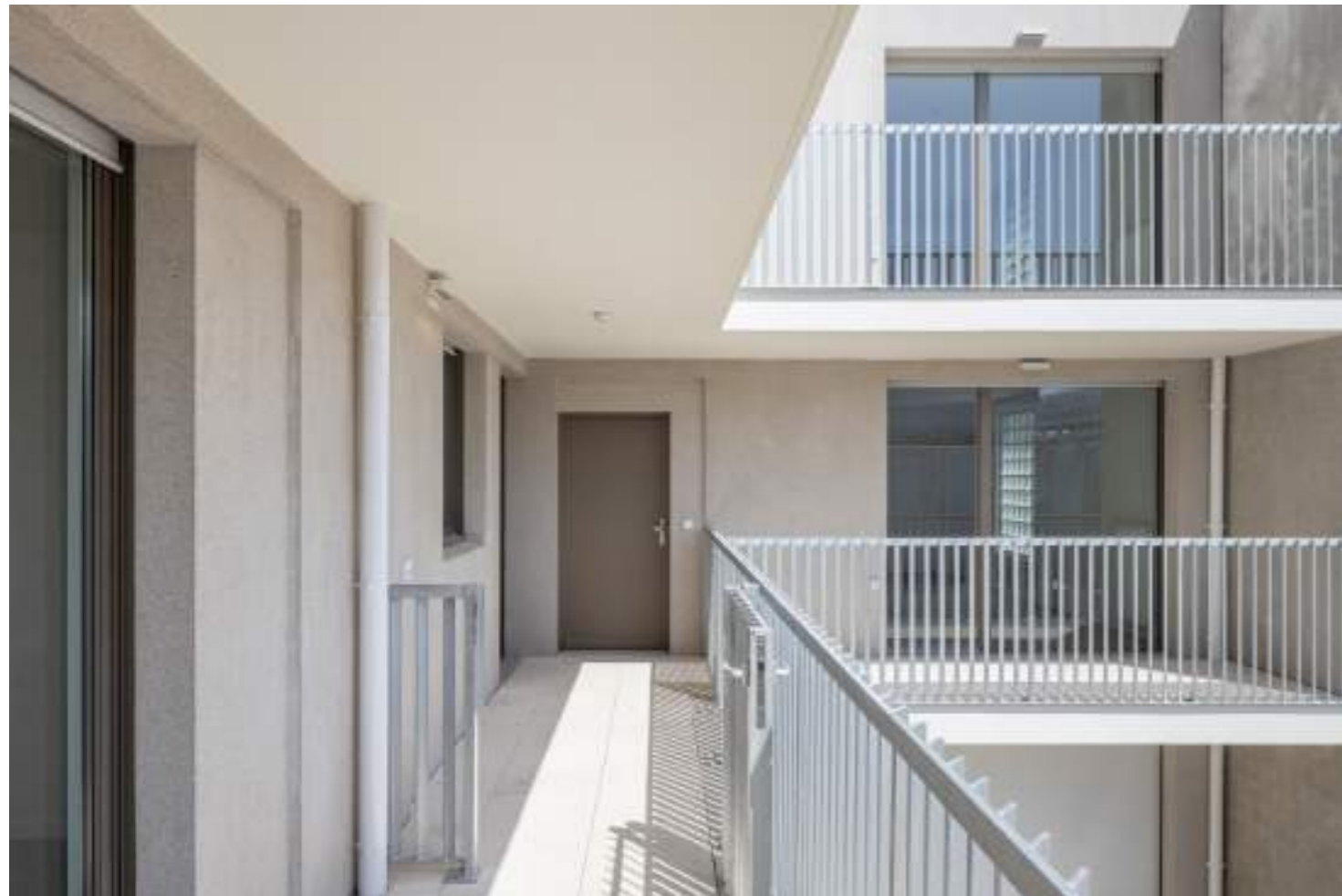
↓ circulations extérieures et coursives privées d'accès aux logements
