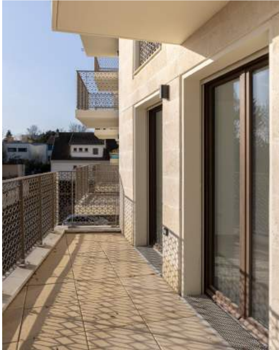
← balcons sur le cœur d'îlot, orientés sud
