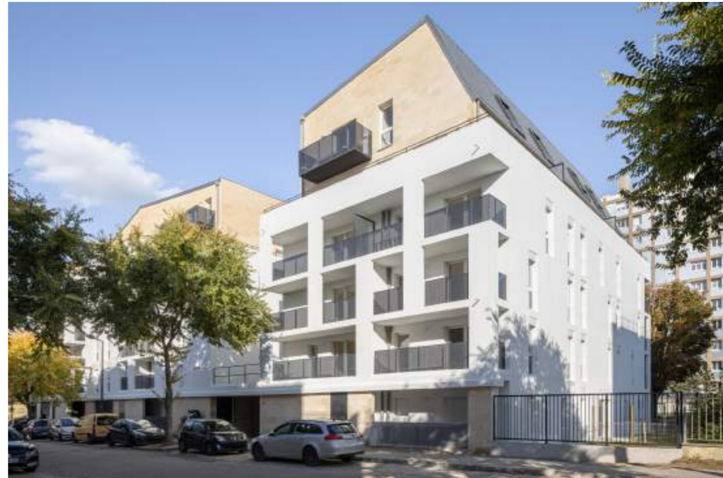
↓ façade urbaine sur rue
